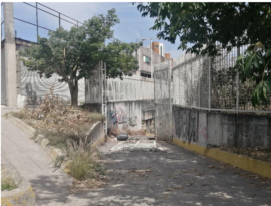
Fotografía 14. Entrada sur del canal en calle Felipe Ruvalcaba
