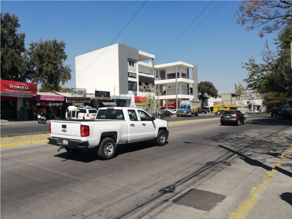
Fotografía 1. Flujo peatonal y vehicular en avenida Nicolás Copérnico
