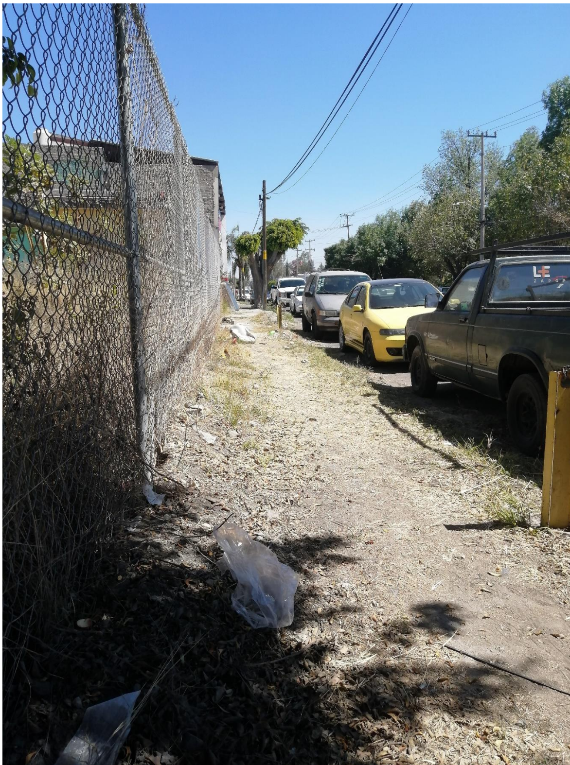
Fotografía 16. Carencia de banqueta en avenida Felipe Ruvalcaba
